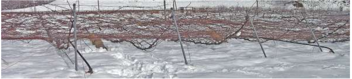
図1 倒壊したぶどう棚
